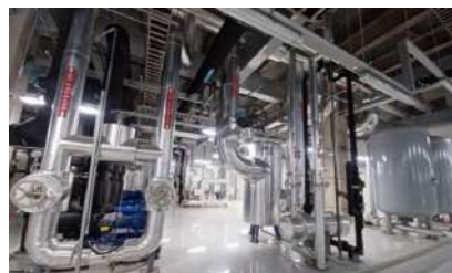
熱水系統由電鍋爐改用瓦斯鍋爐減少碳排放
