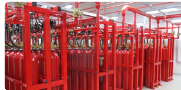
■ 自動氣體滅火系統設置
